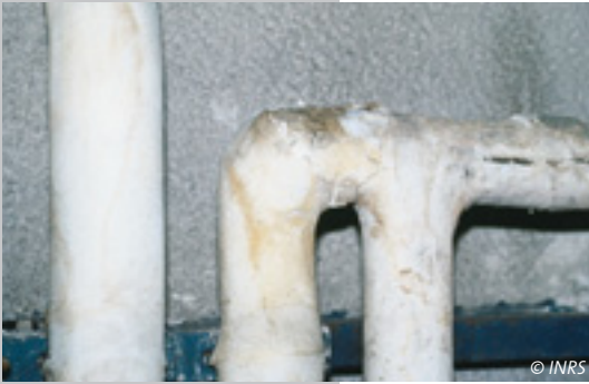
Calorifugeage de canalisations
