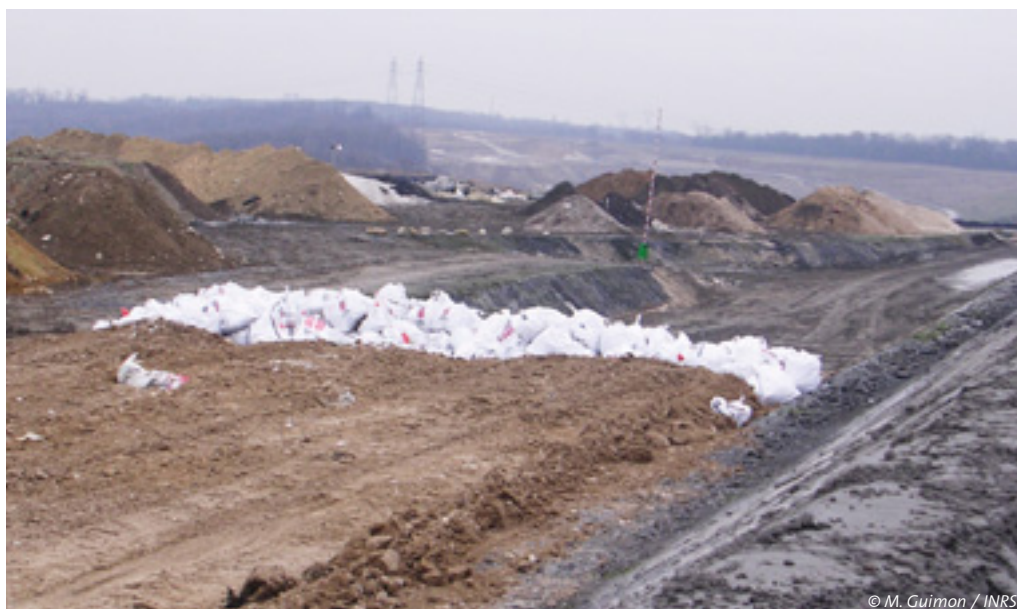
Alvéole amiante en cours d'exploitation. Recouvrement à l'avancée.
