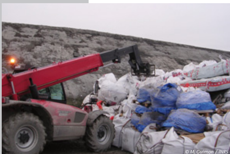
Dépose d'un GRV dans une alvéole
