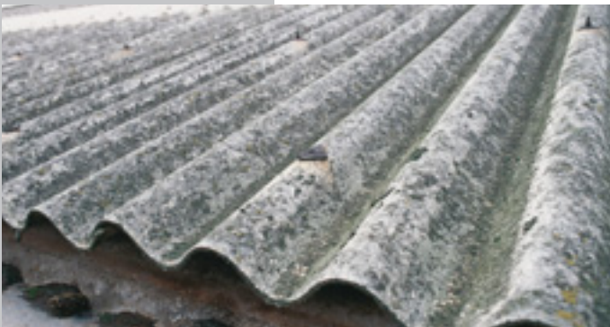
Plaques de toiture en amiante-ciment
