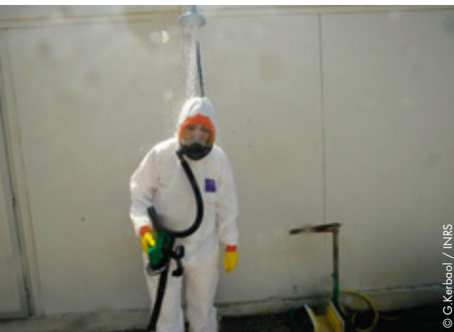
Zone d'approche de l'unité de décontamination équipée d'une douche extérieure
