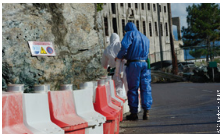
Délimitation du chantier et mise en place de la signalétique
