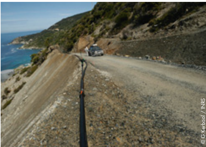
Encapsulage de roche amiantifère par réalisation d'un talus en remblai stabilisé (matériau non pollué)
