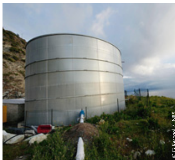
Réserve d'eau permettant d'assurer l'arrosage du site lors des travaux de terrassement
