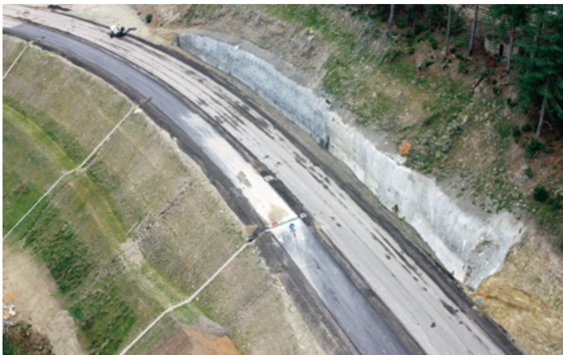
Exemple de couverture de talus routiers sur la RN 193 à Bocognano (2A)
