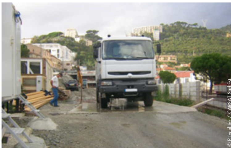
Aménagement de la base vie en zone non contaminée
