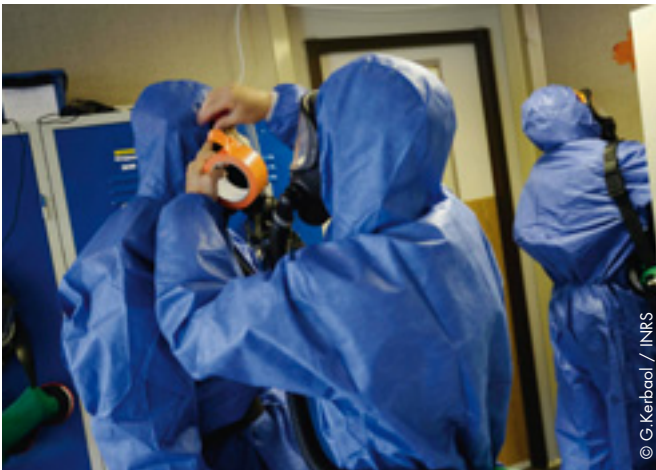
Avant l'entrée dans la zone de travaux, une tierce personne assure l'étanchéité du masque à la combinaison
