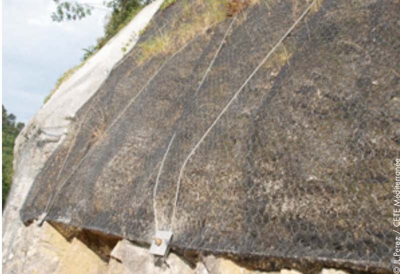
Exemple de revêtement synthétique (géotextile et grillage) posé sur un talus
