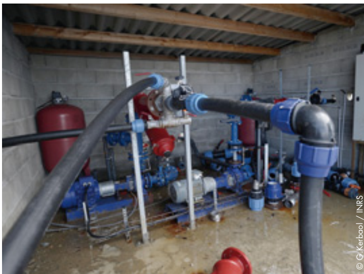
Local technique du réseau de distribution d'eau sur le site
