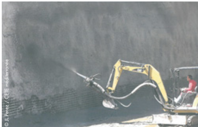
Exemple de projection d'une coque de béton projeté sur treillis soudé
