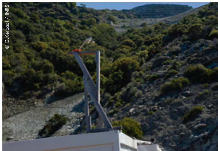
Station météorologique sur le toit de la base sanitaire permettant de vérifier l'orientation et la vitesse du vent
