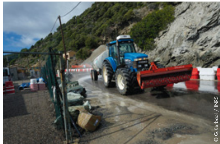
Citerne avec moyen d'aspersion d'eau pour nettoyage de la route d'accès au chantier
