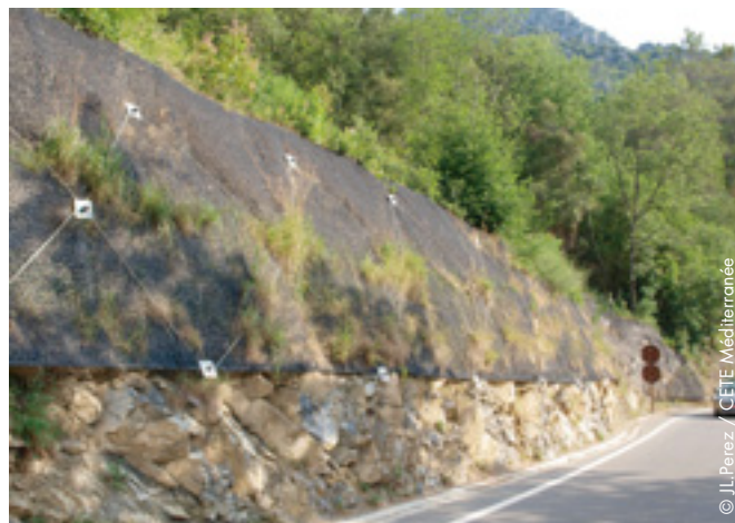
Revêtement synthétique (géogrille en polypropylène et grillage) permettant le maintien du talus
