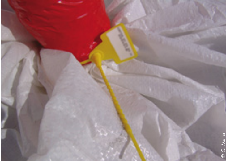
Apposition d'un scellé sur un conditionnement de déchets contenant de l'amiante.
