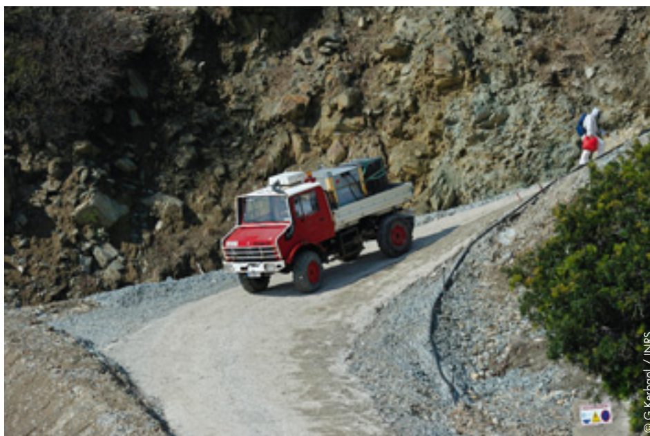
Piste "stabilisée" avec des matériaux inertes permettant la circulation des engins hors risque amiante
