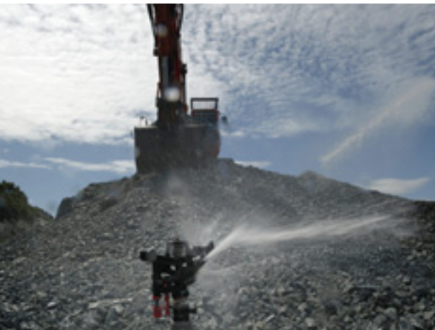
Arrosage par système fixe au plus près de la zone de travaux
