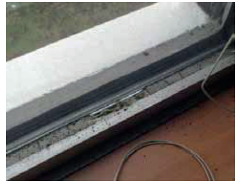
Joints de fenêtres
