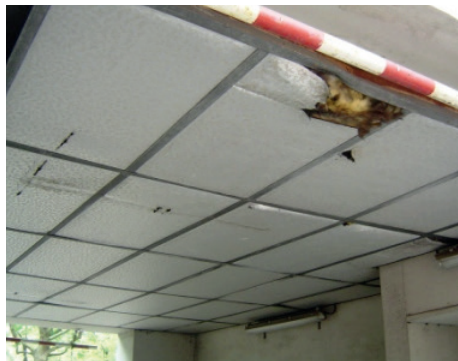
Isolation sous toiture
