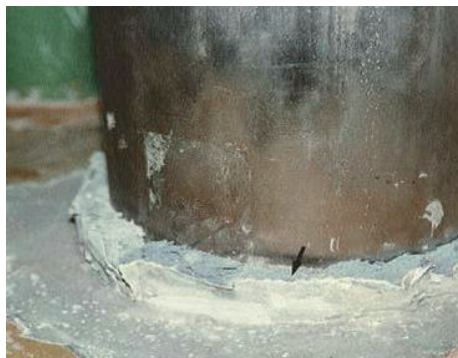
Enduit de rebouchage
