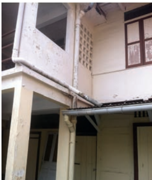
Descente eaux pluviales
