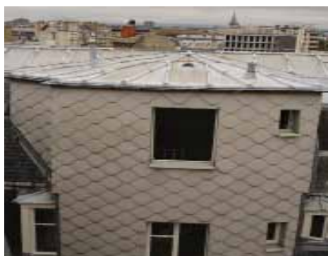
Bardages de façade
