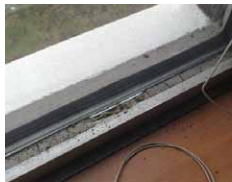
Joints de fenêtres
